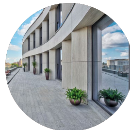
Офіс «Інтергал-Буд М8», м. Київ, вул. Московська
