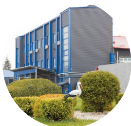
Завод з виробництва електричних кабельних мереж «Електроконтакт Україна», м. Броди, Львівська обл.
